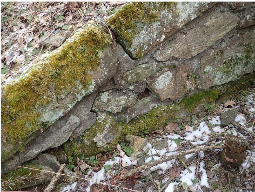
Foto 3: Vypadané spárování mezi kameny v křídle
